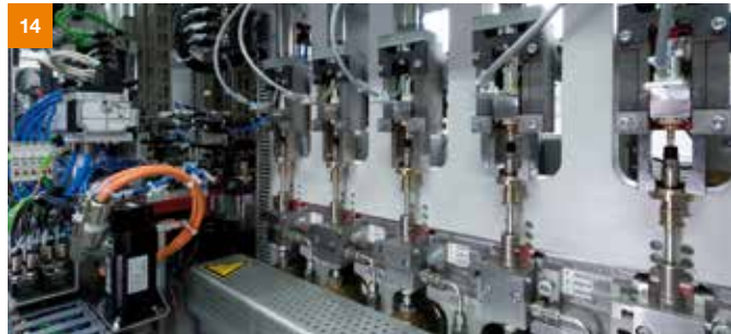
14 Anschließend findet die Dichtigkeitsprüfung statt.
